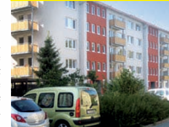
... und nach den umfangreichen Sanierungsarbeiten
