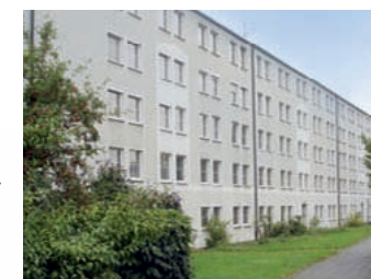
Der Zustand der Fassaden vor der Sanierung ...
