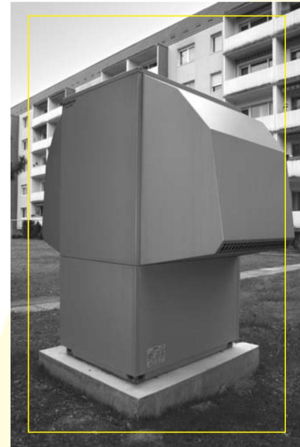
Über diese Luft-Wasser-Wärmepumpe mit einer Leistung von 25 kW werden 40 Wohnungen mit Warmwasser versorgt.
