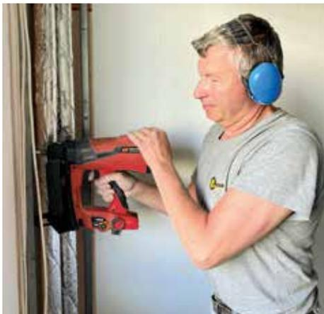
Uwe Matthes beim Montagearbeiten der neuen Heizungsrohrkanäle
